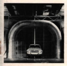
Hier entstand die strömungsgünstige Form des Taunus 17 M: im Windkanal. Sie macht den Luftwiderstand kleiner. Und damit auch den Benzinverbrauch. 8,1 Liter Normalbenzin braucht der 1,5-l-Motor auf 100 km (nach DIN).
